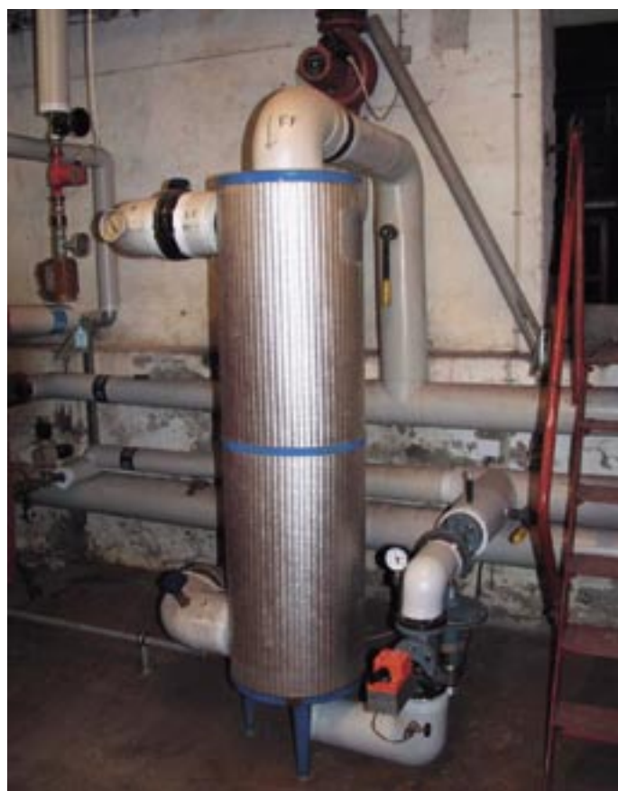
Moderniseringen af det et-strengede anlæg er enkel med en ny motorventil, en stor trykdifferensregulator, følere på frem- og returløb samt udeføler, en kraftig pumpe og en klimastat Clorius KC 2002.
