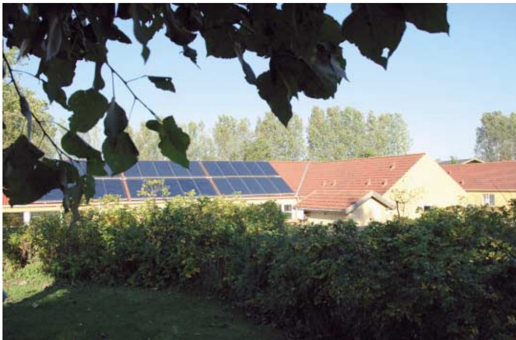
Af miljømæssige hensyn besluttede skolens bestyrelse, at en del af opvarmningen skulle ske ved solvarme.
